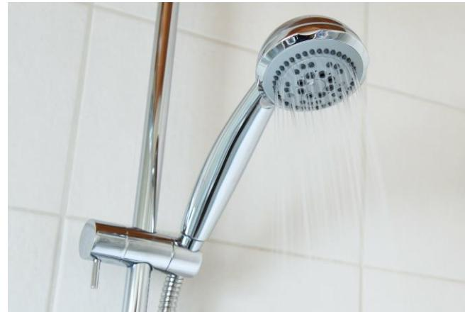
Rast legionela usporava se na višim temperaturama vode i na  $46^{\circ}\text{C}$  prestaje. Bakterija može preživjeti nekoliko sati na temperaturi od  $50^{\circ}\text{C}$ , nekoliko minuta na  $60^{\circ}\text{C}$ , a praktički ne preživjava  $70^{\circ}\text{C}$ .
